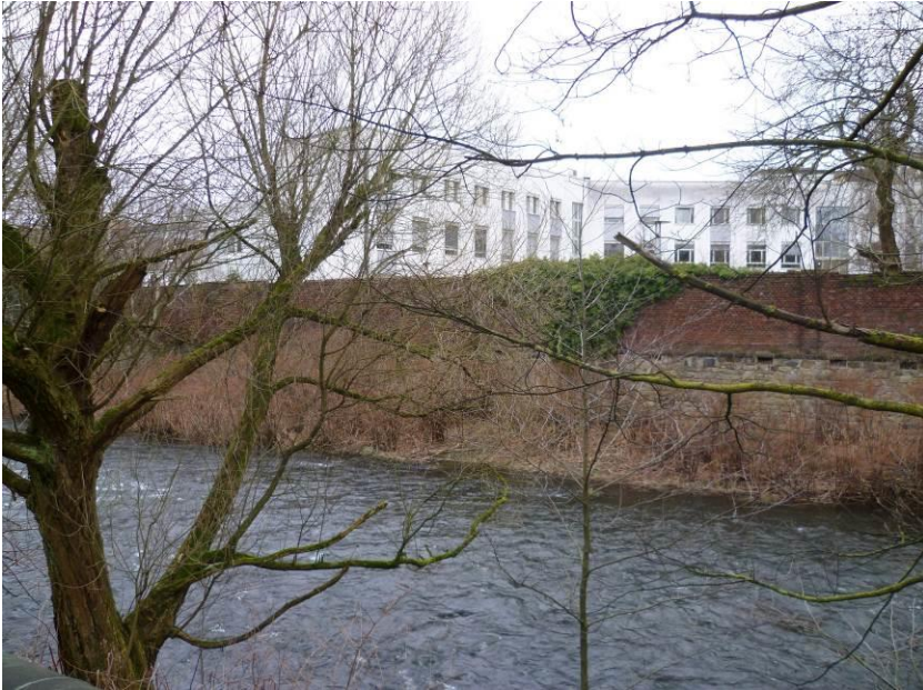
Abbildung 10: Mauer Vorwerk Gelände
